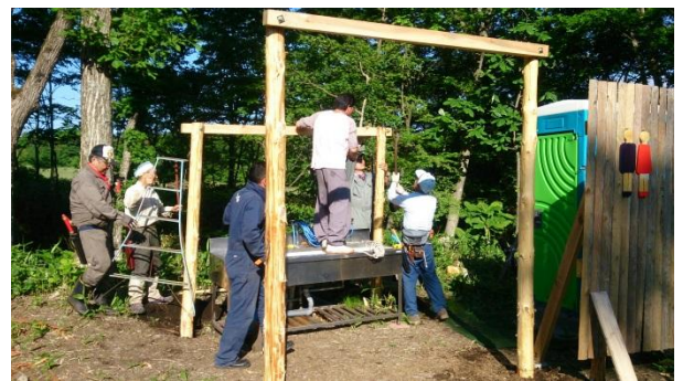
流し台に屋根掛け 柱は檜と唐松の間伐材
