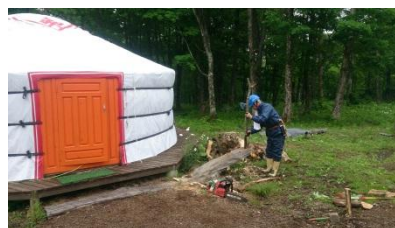
杭を打って散策路の出来上がり
