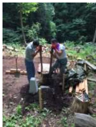
13日にはレーザー墨出し機を使って基礎作り
