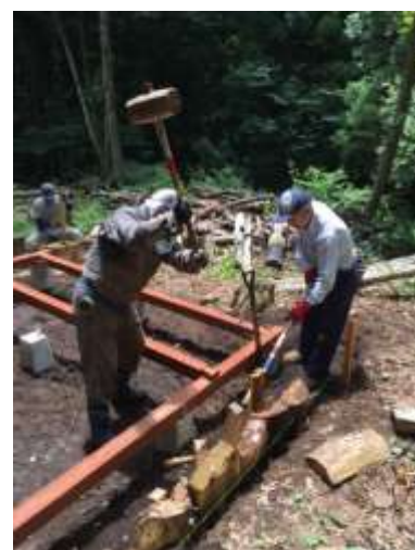
テラス山側の切土への土止め
