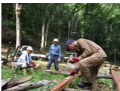
土台の防腐剤塗り
